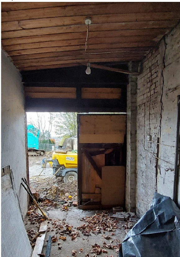
End wall- garage door
