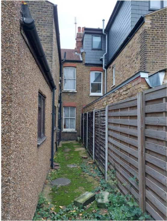
④ External passage
