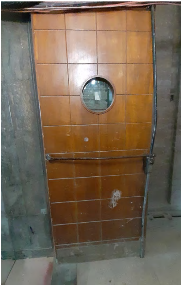
89C G.49 Vestibule inner entrance door
