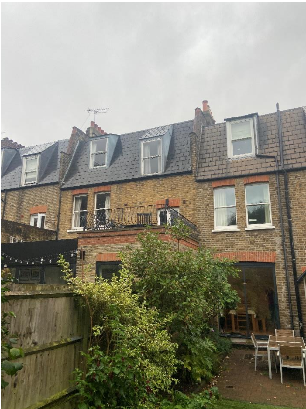
Site Photos - Date 16.01.24
