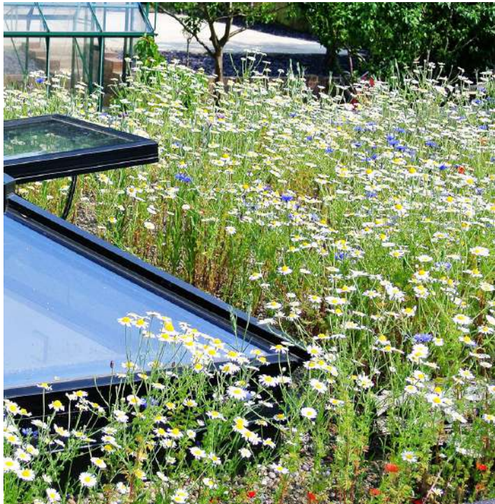
Biodiverse green roof
