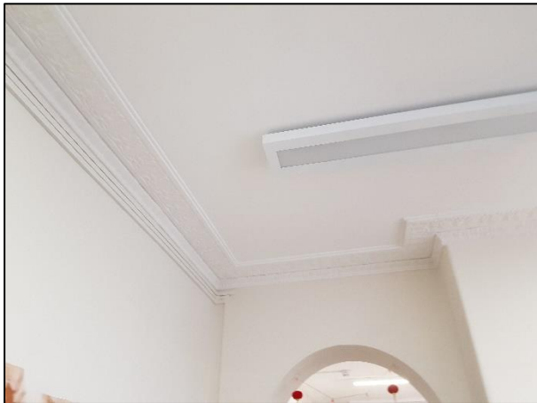
Figure 41: Level 1 Cornice (D)
