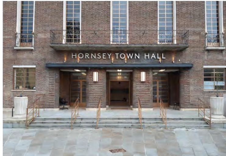
89 G.49 Vestibule external
