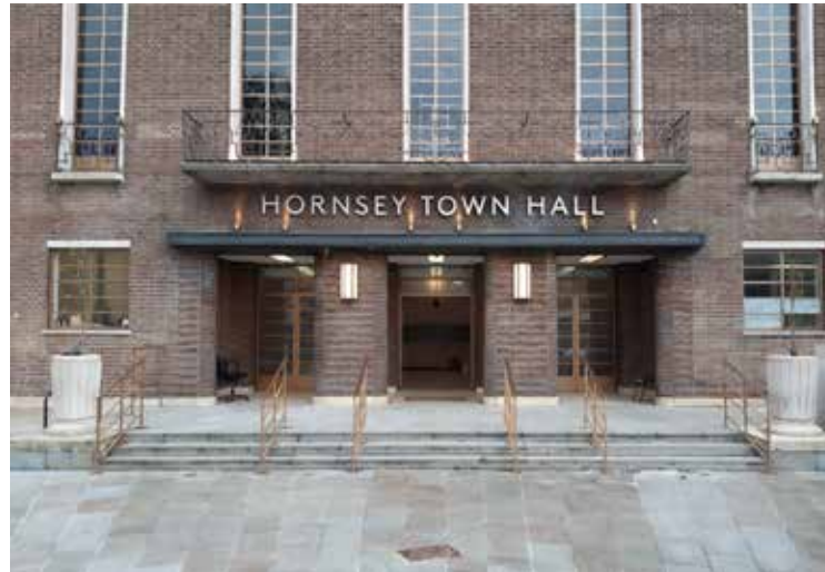
89 G.49 Vestibule external
