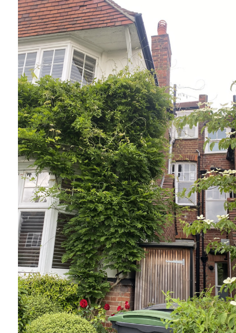
2. Existing Front Door - 34 Fortismere Avenue
