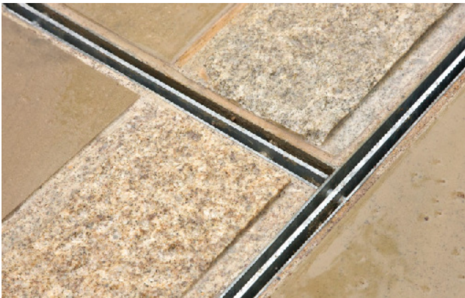
Linear slot drains
