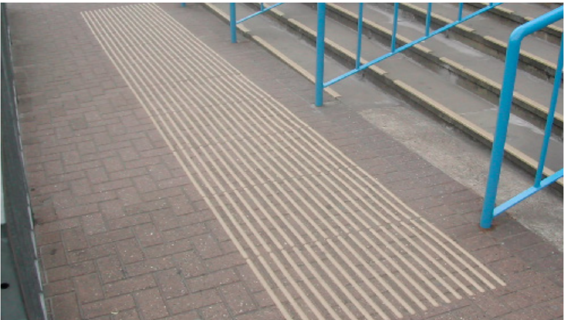
Corduroy strips - Multitread Tactile Indicators
